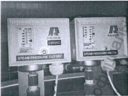
Рисунок 3 Регуляторы давления пара
