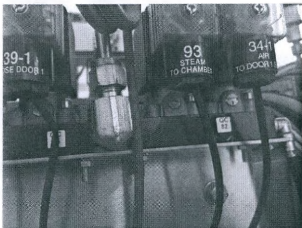
Рисунок 8 Электромагнитные клапана управления
