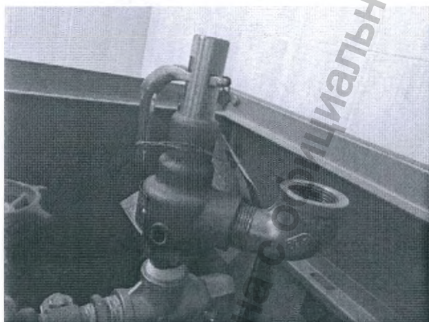
Рисунок 19 Предохранительный клапан
