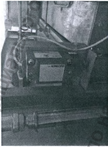
ממוקם בצד ימין באזור הטכני-שמאחורי הלוח הקדמי אוויר מתג הגבלה לדלת
