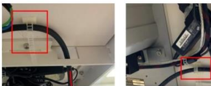
Рисунок 27: Стяжки для прокладки кабеля
