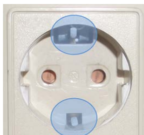
[Положение заземления электрической розетки]
