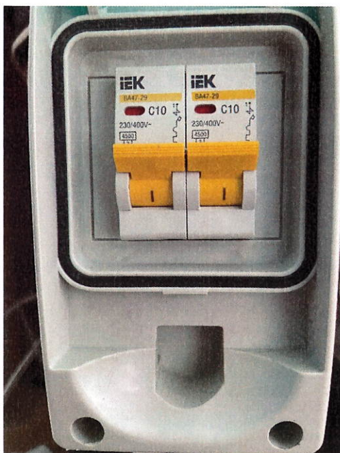
Рис. 46 Автоматические выключатели
