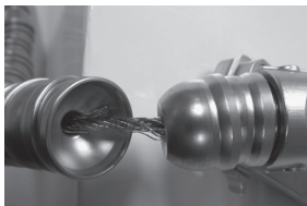
图 8 – 出现疲劳和磨损的线缆
