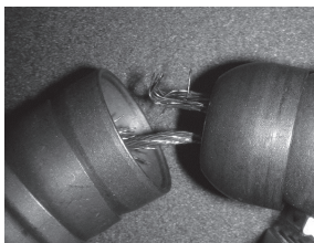
图 4 – 磨损线缆外观 – 请勿使用
