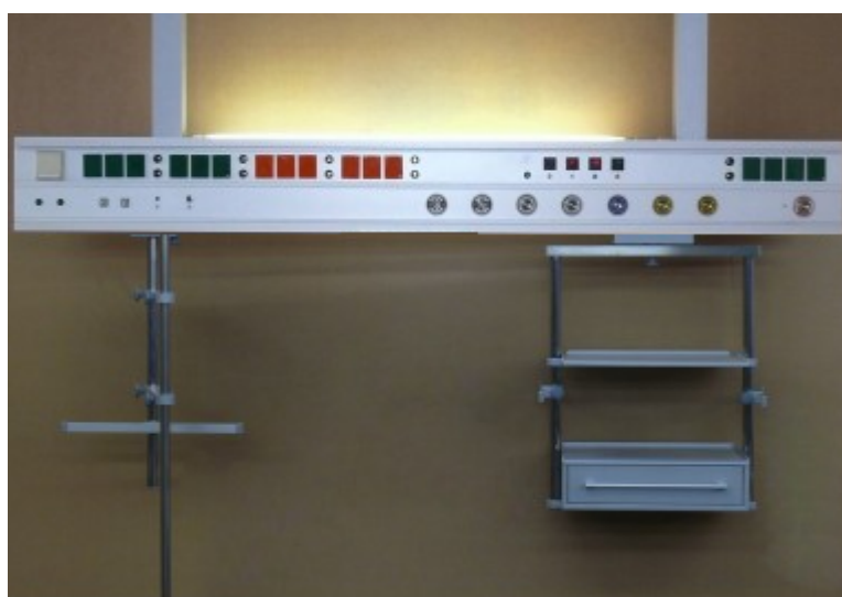
Рис. 2 Консоль потолочная с подвижными секциями IMT-3300-R(L)-ПТ
