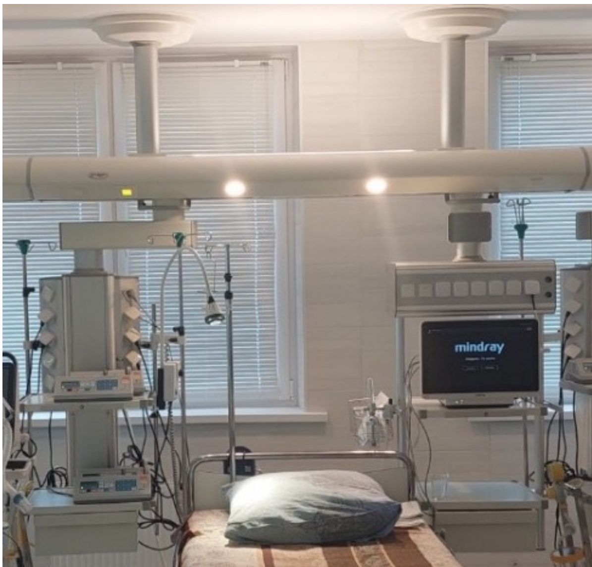
Рис. 7 Консоль потолочного крепления с двумя подвижными секциями на поворотных плечах и встроенными светильники общего и ночного освещения IMT-3500-L(R)-ПТ
